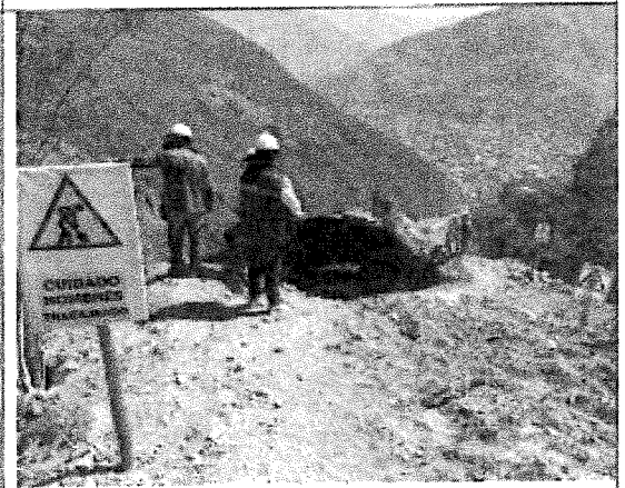
Imagen n.º 4: Se presenció los trabajos de instalación de geoceldas en el tramo II.
