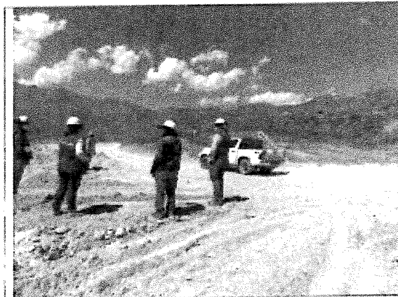
Imagen n.º 1: Inspección del DME 2, ubicado en Llicua Alta.
