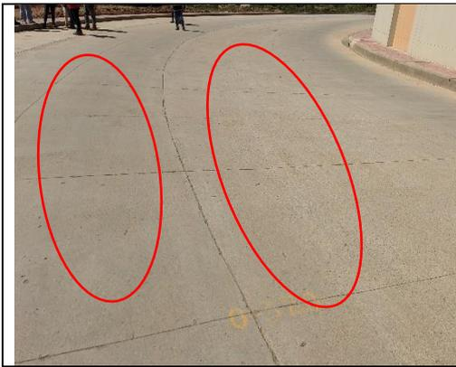
**Fotografía n.º 3.** Pavimento rígido con presencia de desgaste de la superficie de rodadura entre las progresiva 0+320
