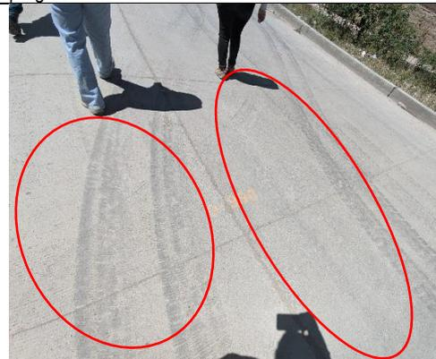
**Fotografía n.º 7.** Pavimento rígido con presencia de desgaste de la superficie de rodadura entre las progresiva 0+990
