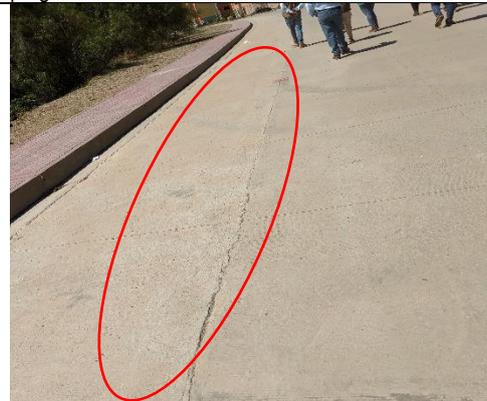
**Fotografía n.º 5.** Pavimento rígido con presencia de desgaste de la superficie de rodadura entre las progresiva 0+500
