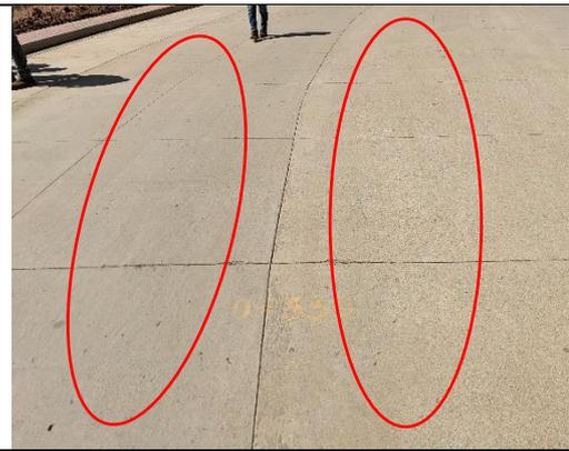
**Fotografía n.º 4.** Pavimento rígido con presencia de desgaste de la superficie de rodadura entre las progresiva 0+330
