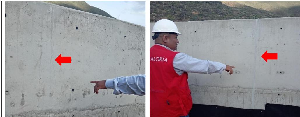
**Fotografía n.ºs 1 y 2** Muro de concreto ubicada en la progresiva 0+800 al 0+840 con presencia de fisuras verticales.
