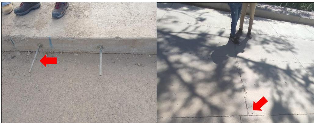
**Fotografía n.º 1.** Se observa los Dowel longitudinales colocada en el pavimento antiguo.
