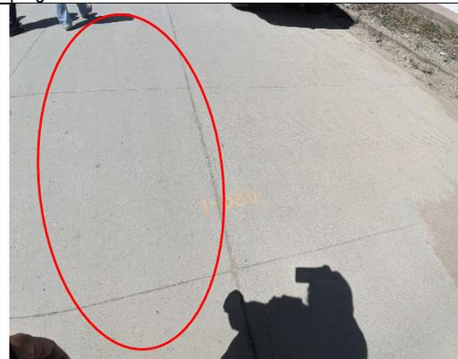
**Fotografía n.º 8.** Pavimento rígido con presencia de desgaste de la superficie de rodadura entre las progresiva 1+030
