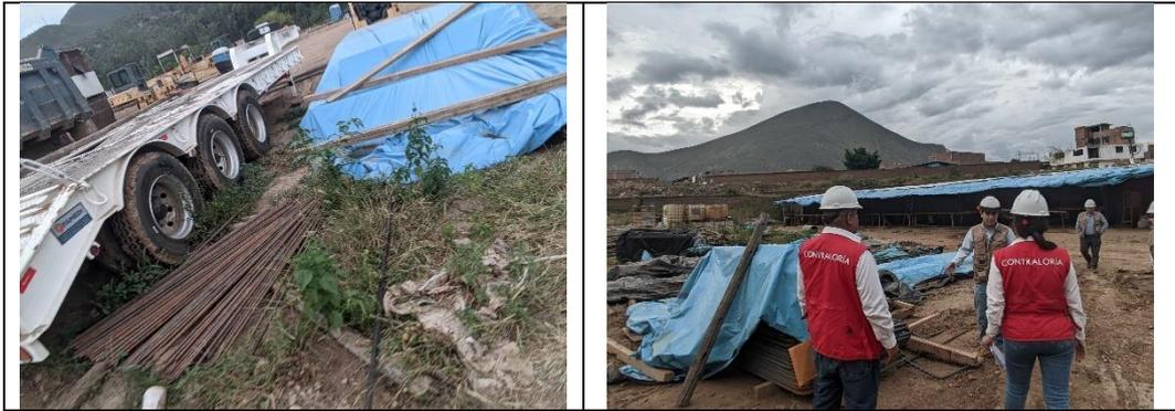
Barras de acero al contacto del terreno natural, con presencia de óxido y al costado de la maquinaria.
