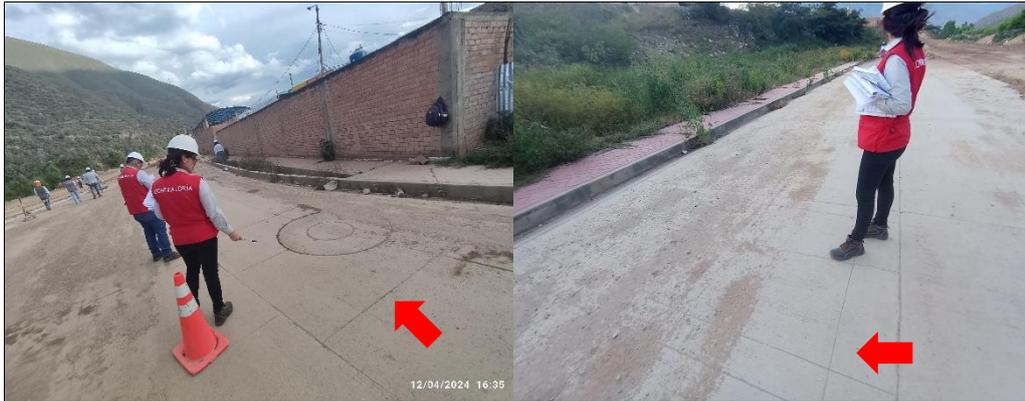
**Fotografía n.º 3.** Se observa los cortes transversales de las juntas en las tapas de buzón sin la continuidad correspondiente a los demás paños
