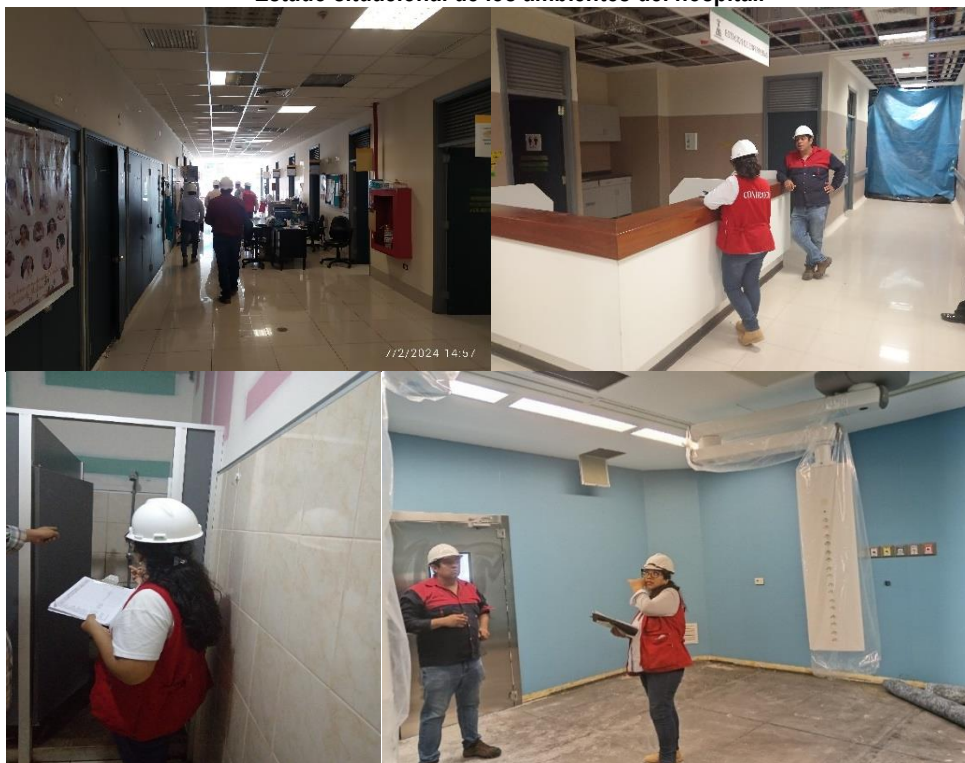
Imagen n.º 10 Estado situacional de los ambientes del hospital.
