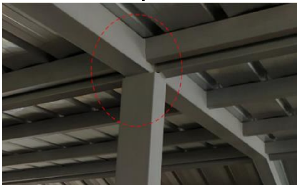
Imagen n.º 19 Perfil longitudinal en "I"
