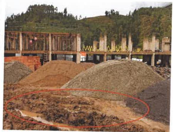
**Descripción:** Materiales "agregados" expuestos a la intemperie en contacto con los fenómenos meteorológicos y otros agentes contaminantes.
