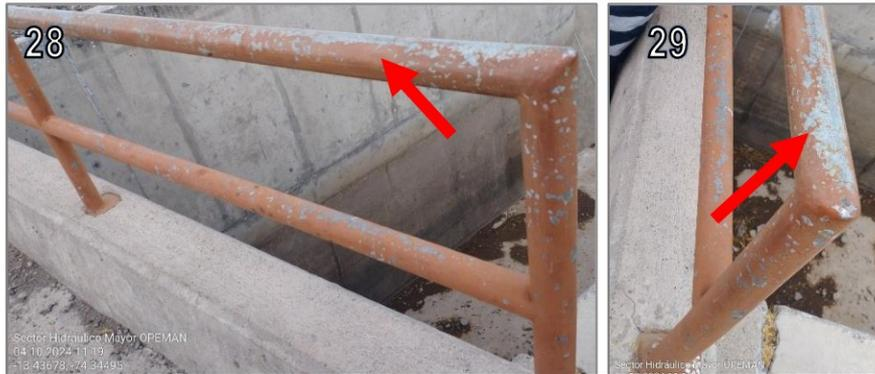
En las imágenes n.ºs 28 y 29 se observa el desgaste de la pintura en las barandas ubicadas sobre el aliviadero de la presa Cuchoquesera.
