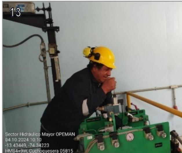
Imagen n.º 12: Se visualiza el comando local para la operación de la regulación de la válvula. Imagen n.º 13: Dificultades en la activación del motor, se necesita acción física del personal técnico.
