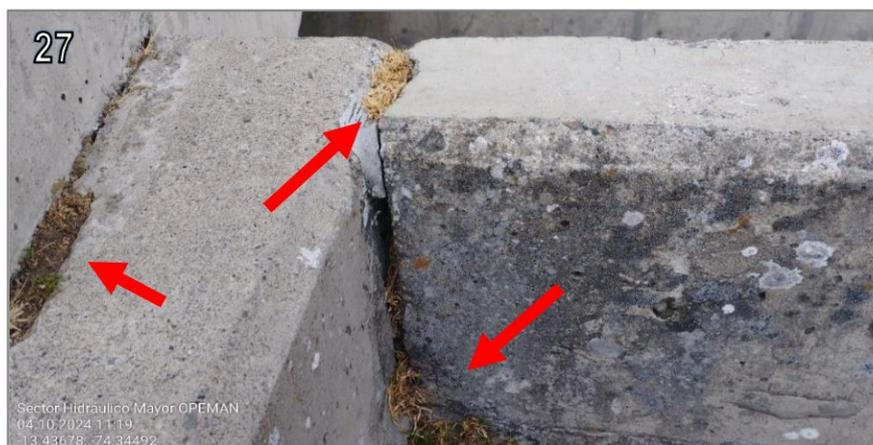
En la imagen n.º 27 se puede observar el crecimiento de gramíneas ("pasto") en la estructura de cemento en las juntas de dilatación (uniones).
