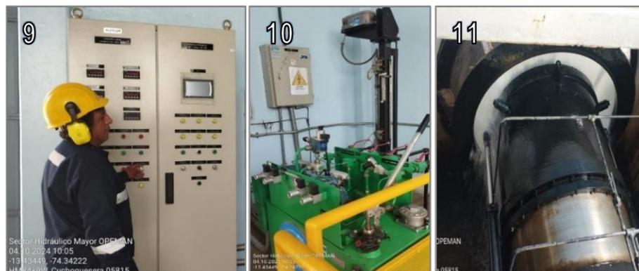
Imagen n.° 9: Caja de mando, se visualiza el led de comando y alarmas (controladores), Imagen n.° 10: Motor, Imagen n.° 11: Válvula Howell Bunger "HB" (regula salida del agua)
