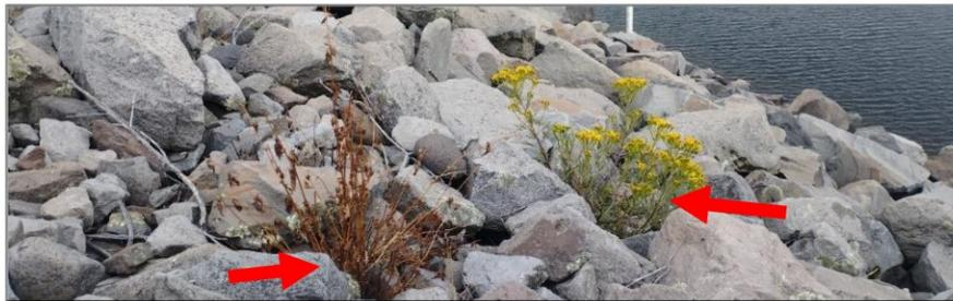
En la imagen n.º 30, se puede observar el crecimiento de vegetación entre las piedras del revestimiento de la presa Cuchoquesera.
