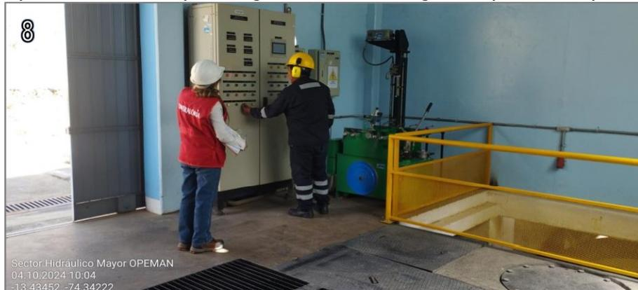
Imagen n.° 8: Vista de la caseta de válvulas (lugar donde se realiza la regulación, apertura y cierre de la salida del agua de la presa Cuchoquesera)
