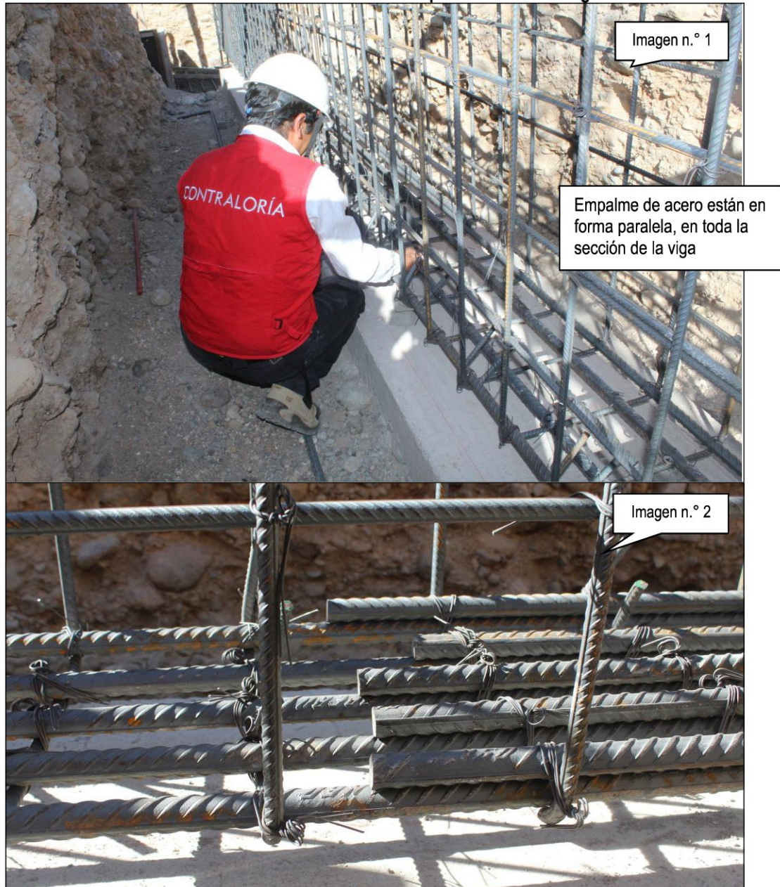
Imágenes n.ºs 1, 2 Y 3 Proceso constructivo deficiente en empalme de acero en vigas
