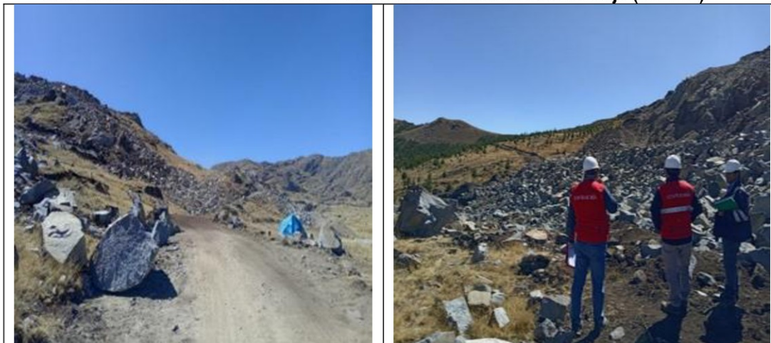
Imágenes n.ºs 6 y 7: Se evidencia frente de trabajo 3, sin señalización de seguridad lo que podría generar daños físicos
