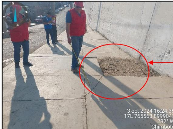
Falta de ejecución de rampas de acceso para personas minusválidas y fisuras en el concreto de la vereda
