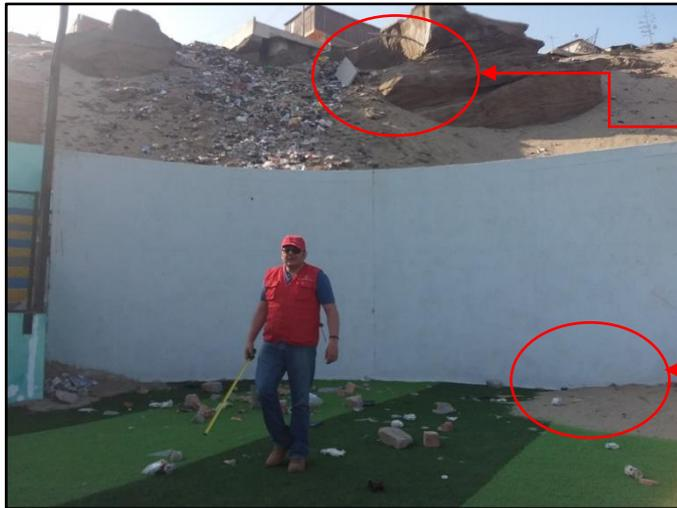
Desprendimiento de plataforma de concreto por erosión del suelo y material de arena fina suelto que pone en riesgo la infraestructura del Estadio San Pedro.
