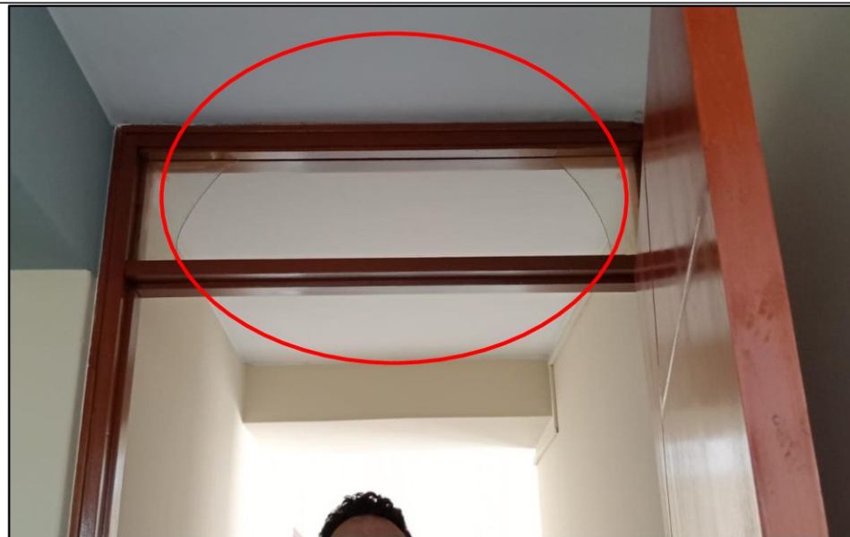
FOTOGRAFÍA N° 13 SE OBSERVA EL VIDRIO DE LA PUERTA ROTO, SIN EMBARGO, SEGÚN EL EXPEDIENTE TÉCNICO DEL SERVICIO SOLO SE HA CONSIDERADO EL CAMBIO DE LAS HOJAS DE LA MAYORÍA DE LAS PUERTAS
