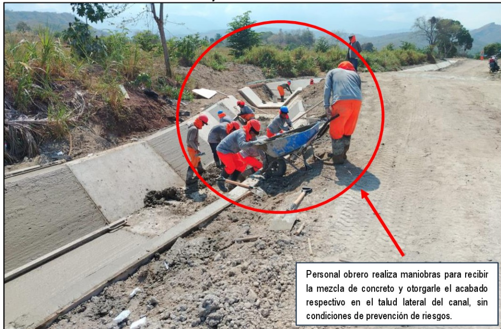
Imagen n.º 12 Obreros realizando trabajos de recubrimiento de canal en taludes
