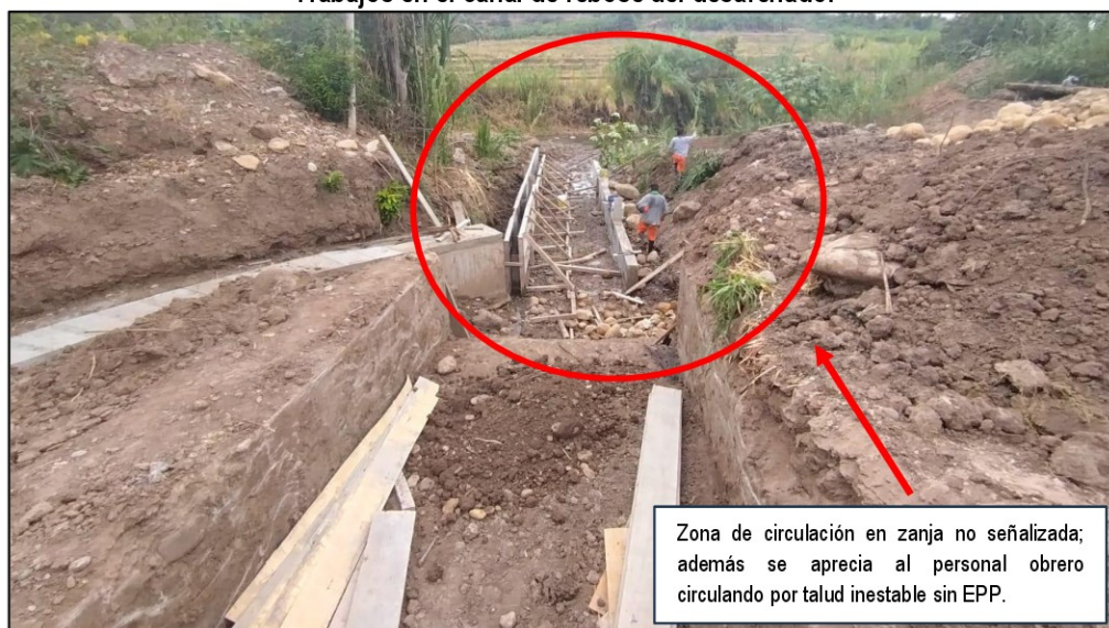
Imagen n.º 14 Trabajos en el canal de rebose del desarenador
