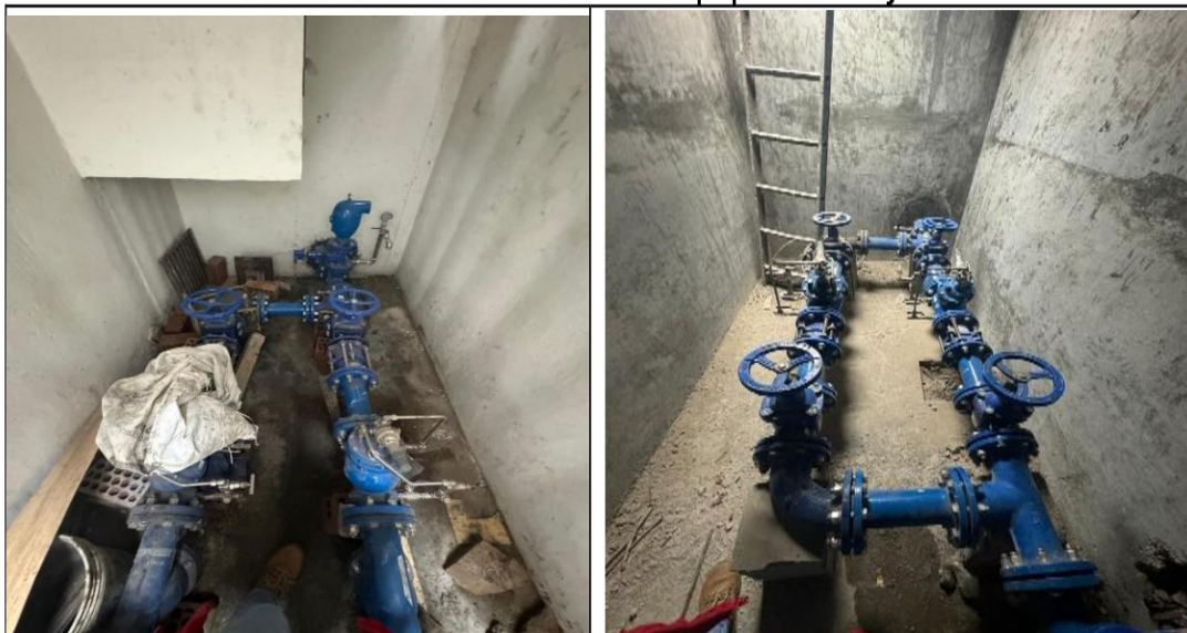
Imagen n.º 7 y 8 Vistas interiores de las cámaras de rompe presión n.º 3 y 4
