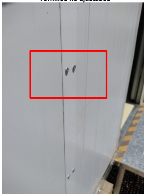
Imagen N° 15 Tornillos no ajustados
