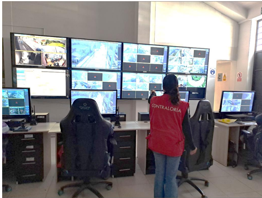
IMAGEN N° 1 SALA DE MONITOREO DE LAS CAMARAS DE VIDEO VIGILANCIA
