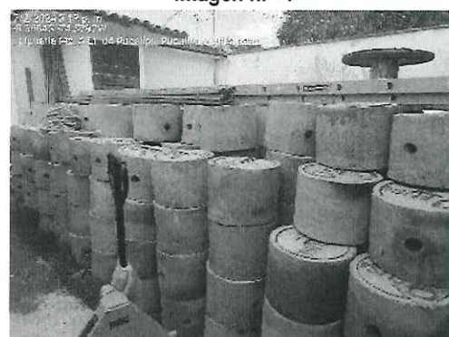
Cajas de registro para PAT
