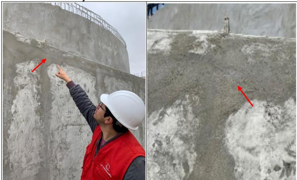
**Nota:** Se puede observar en el muro de contención otra fisura y que sobresale otra pieza de madera, la cual está adherida entre el concreto.
