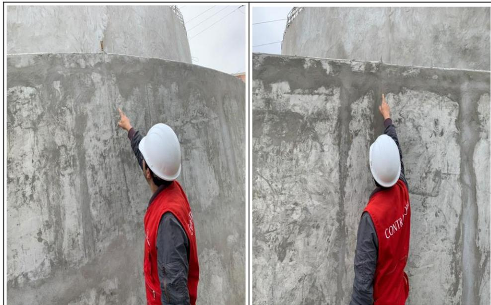
**Nota:** Se puede observar manchas en el concreto del muro de contención.
