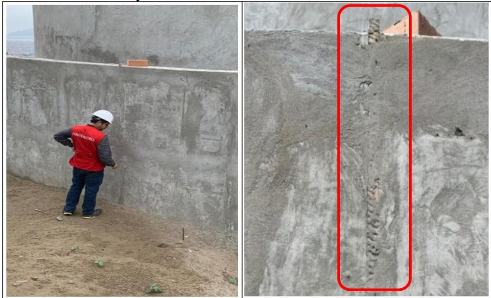
**Nota:** Se puede observar en el muro de contención una fisura y que sobresale una pieza de madera, la cual está adherida entre la unión de los paños de concreto.
