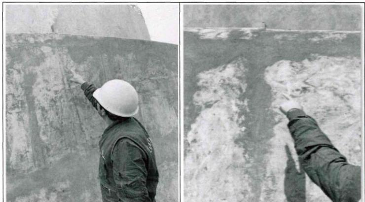
**Nota:** Se puede observar en el muro de contención otra fisura y que sobresale otra pieza de madera, la cual está adherida entre el concreto.
