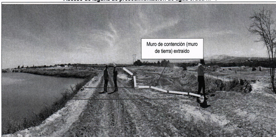
Acceso de laguna de presedimentación de agua cruda n.º 1
