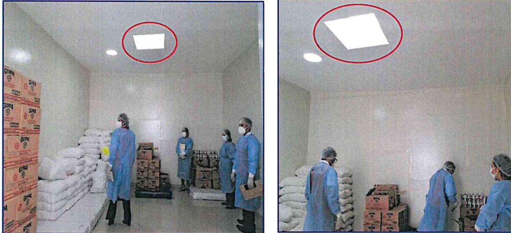
Fuente: Acta de Constatación N° 003-2024-MPH/OCI de 3 de abril de 2024 Elaborado por: Comisión de Visita de Control
