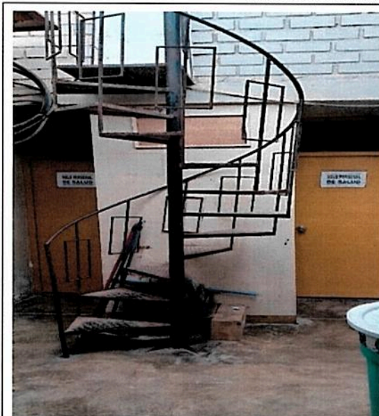
Imagen n.º 17: Escalera que permite el acceso al tercer piso se encuentra en mal estado.
