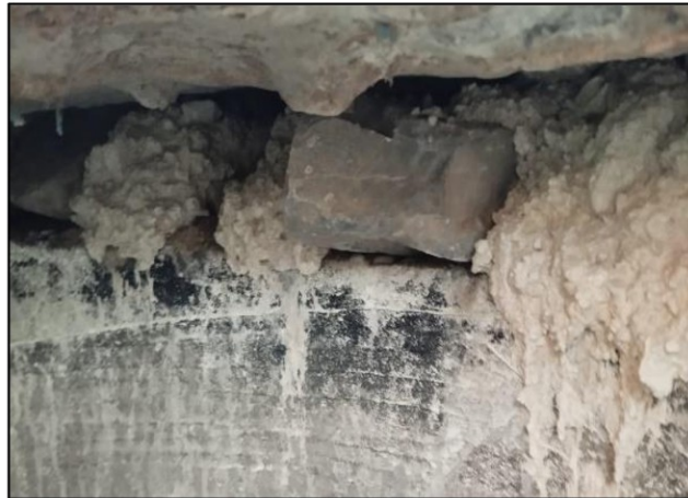
Fuente: Inspección física de obra de 17 de setiembre de 2024 Elaborado por: Comisión de control.
