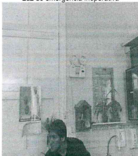
Imagen n.º18 Luz de emergencia inoperativa
