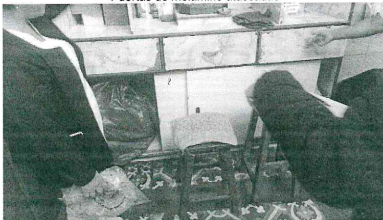
Imagen n.º12 Puertas de melamine atascadas
