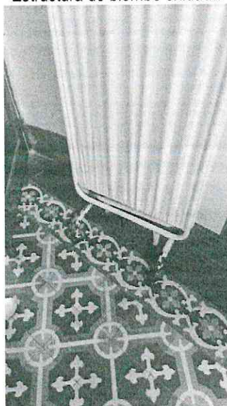
Imagen n.º09 Estructura de biombo oxidada
