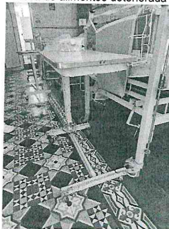
Imagen n.º12 Mesa de alimentos deteriorada
