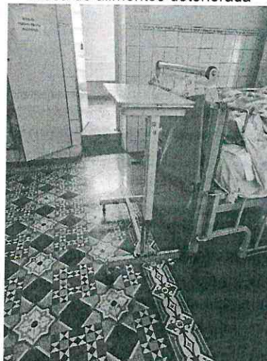
Imagen n.º14 Mesa de alimentos deteriorada
