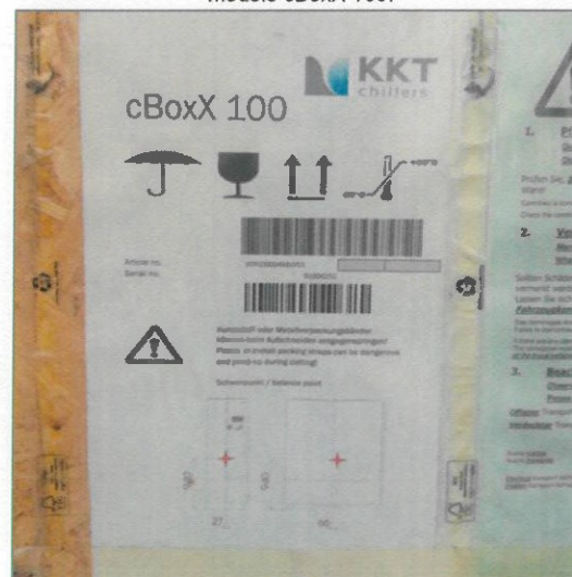
Imagen n.º 6: Hoja técnica adherida a la caja de madera aglomerada, que indica Características de Chiller n.º 2: KKT, modelo cBoxX 100.
