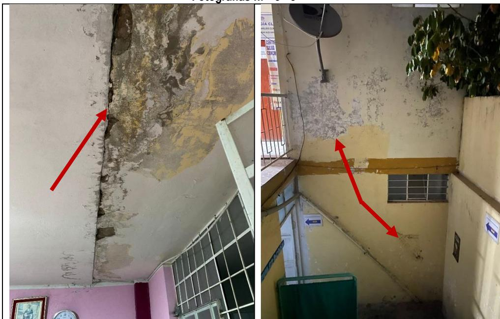
**Fotografía n.º 3:** Se muestra parte interna del techo del área de “Emergencias y procedimientos” con presencia de filtraciones.
