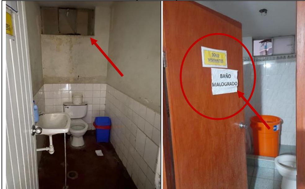
**Fotografía n.º 6:** Se muestra servicios higiénicos del primer piso sin fuente de luz natural y sin luminarias, ni instalaciones eléctricas
