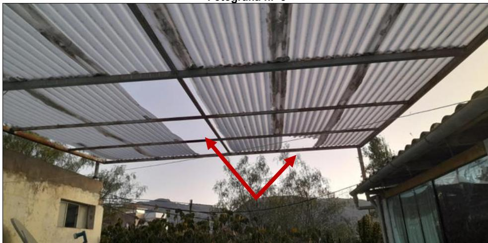
**Fotografía n.º 8:** Techado de patio de segundo piso del centro de salud con secciones faltantes.
