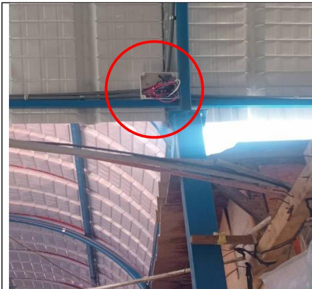
Descripción: Se evidencia caja de paso a punto de salida descubierta, produciendo la exposición de cables eléctricos.
