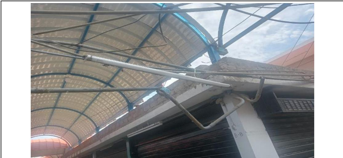
Descripción: Se evidencia la falta de limpieza y desmontaje de tubería antigua, que imposibilita el libre tránsito.
