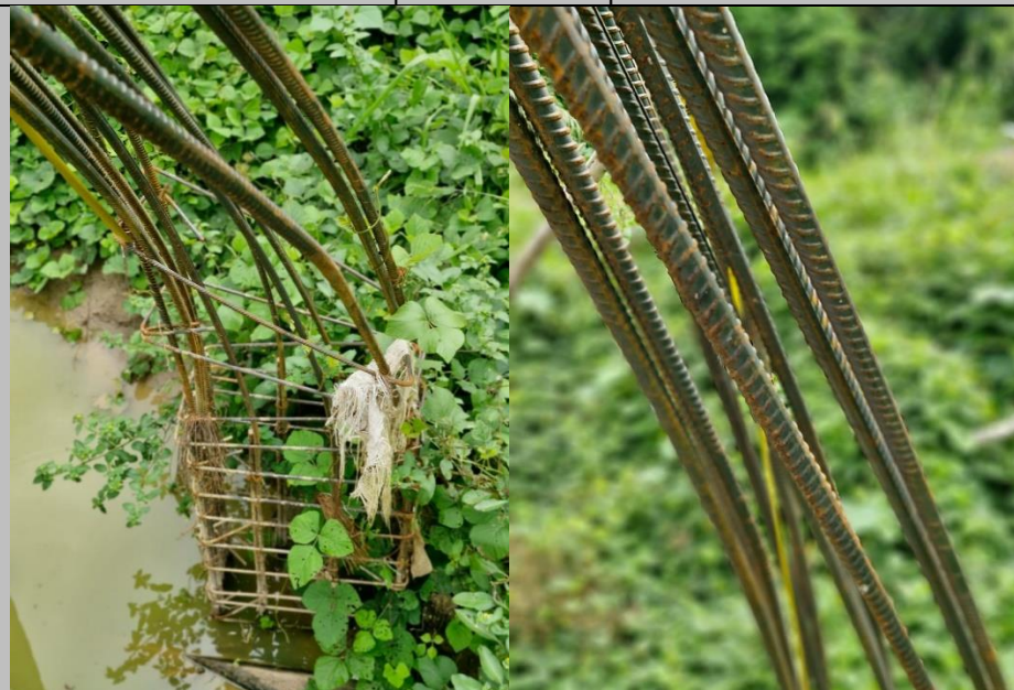
Panel fotográfico n.º6 Varillas de acero habilitadas del estribo expuestas a la intemperie con rastros de oxidación
