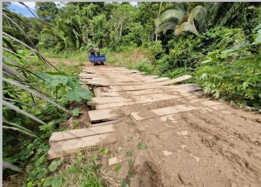
Panel fotográfico n.º3 Puente de madera en malas condiciones, de acceso para el transporte de los pobladores y vehículos de carga pesada.
