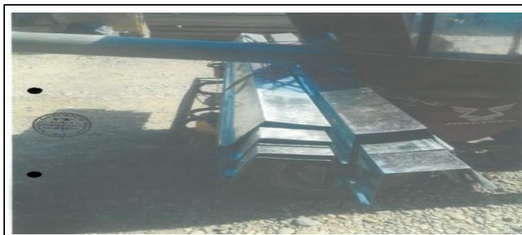
Imagen n.° 23 Adquisición de canaletas
