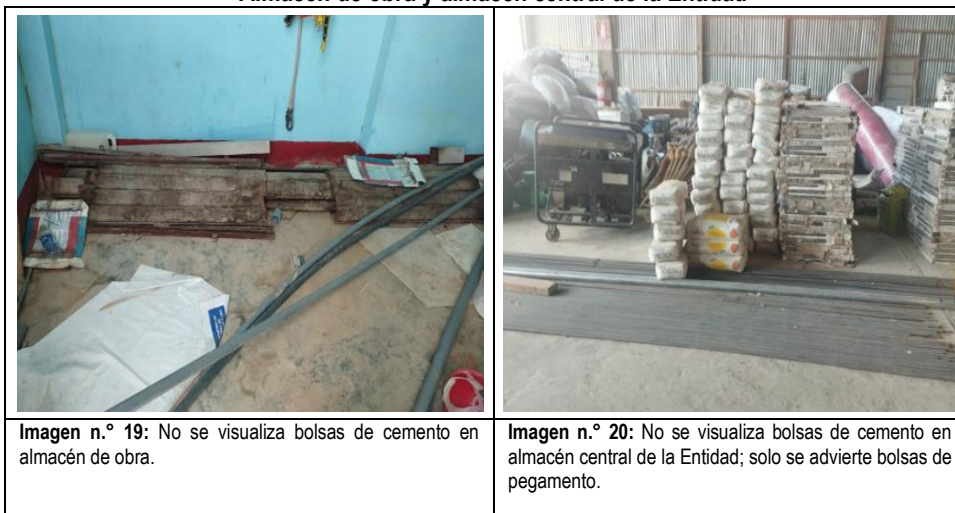
Imagen n.° 19 y 20 Almacén de obra y almacén central de la Entidad
