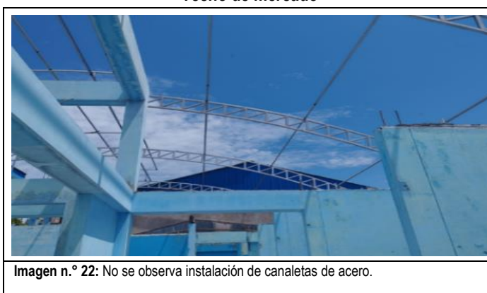
Imagen n.° 22 Techo de mercado
