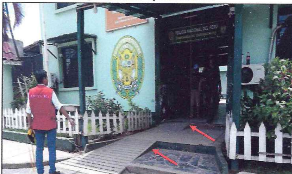
Fotografía n.º 6 Rampas de acceso n.ºs 1 y 2 de la Comisaría
