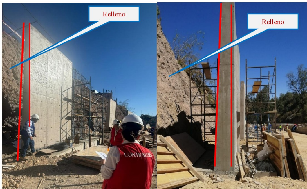
Imagen n.º 8 Muros de contención ejecutados
