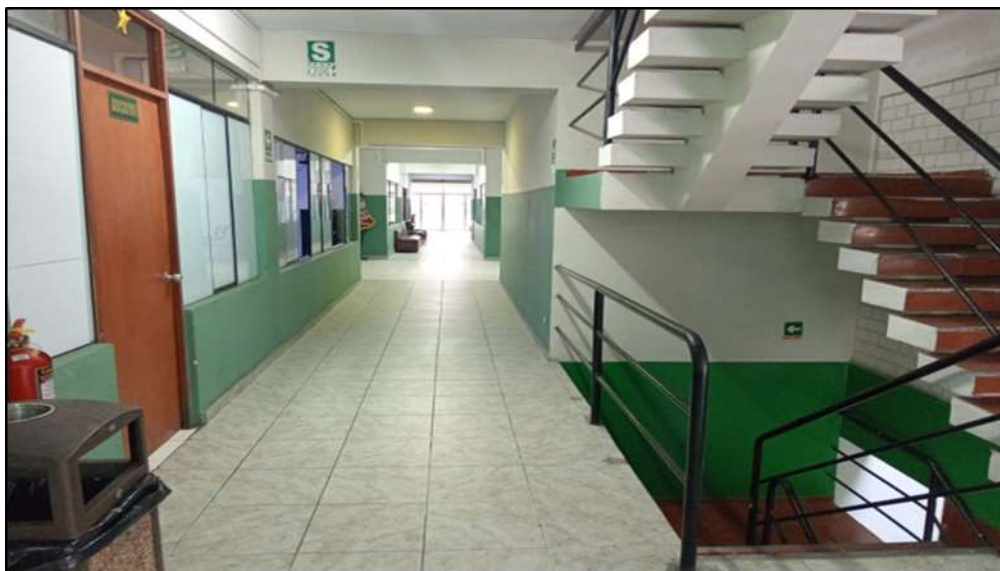
Imagen n.º 3 Se muestra el espacio de desplazamiento libre de obstáculos en la CPNP San Isidro
