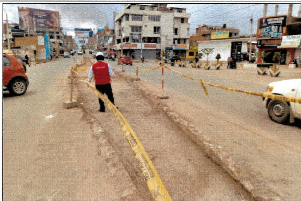
Imagen n.º 2.- Detalle de Berma Central de la Av. Mariscal Castilla después del 26 de octubre de 2024
