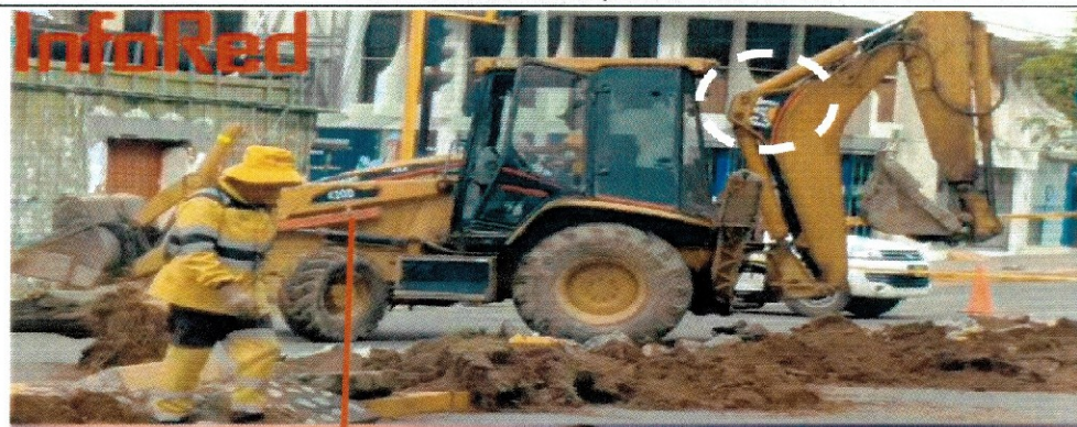
Imagen n.º5.- Retroexcavadora Caterpillar 420D
