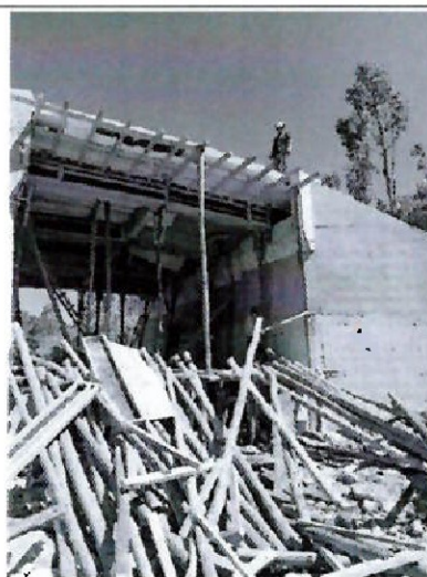
Foto n.º 28: Desencofrado de puente sangal sin supervisión del residente de obra y/o inspector debido a paralización de obra.
