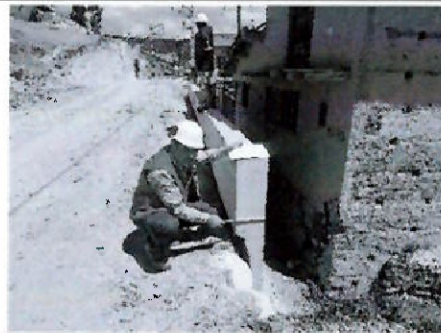
Foto n.º 8: Verificación de medidas en muros de contención.
