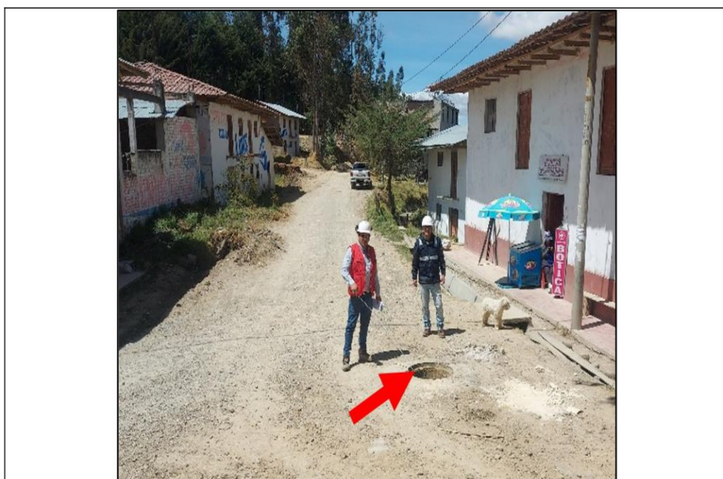
Imagen N° 06 Visualización de buzón sin tapa.
