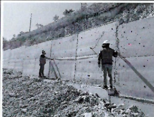
Foto n.º 22: Verificación de medidas en muros de contención.
