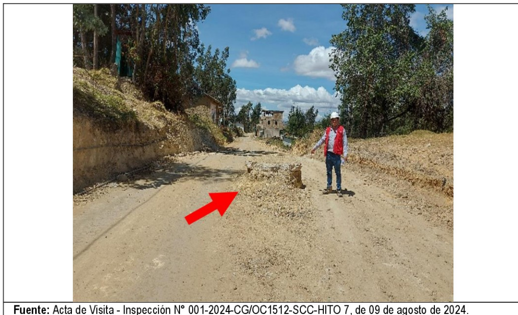
Imagen N° 07 Visualización de buzón sobresalido en eje de la vía
