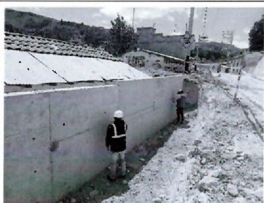
Foto n.º 6: Verificación de medidas en muros de contención.
