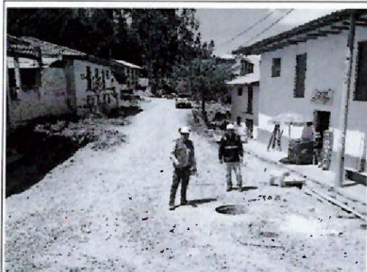
Foto n.º 11: Buzones de desagüe sin tapa.
