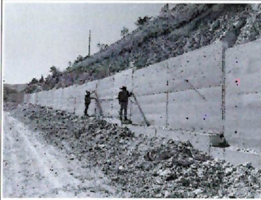
Foto n.º 21: Verificación de medidas en muros de contención.
