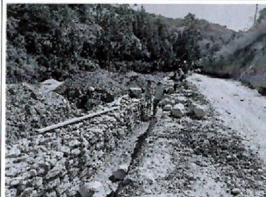
Foto n.º 24: Construcción de muro de gaviones sin dirección técnica ni de seguridad.
