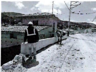
Foto n.º 7: Verificación de medidas en muros de contención.
