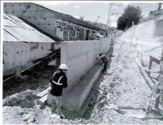
Foto n.º 5: Verificación de medidas en muros de contención.
