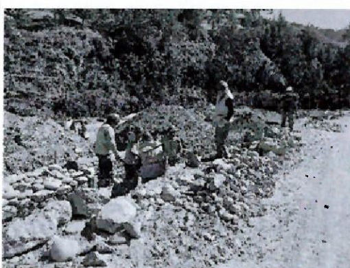
Foto n.º 23: Construcción de muro de gaviones sin dirección técnica ni de seguridad.
