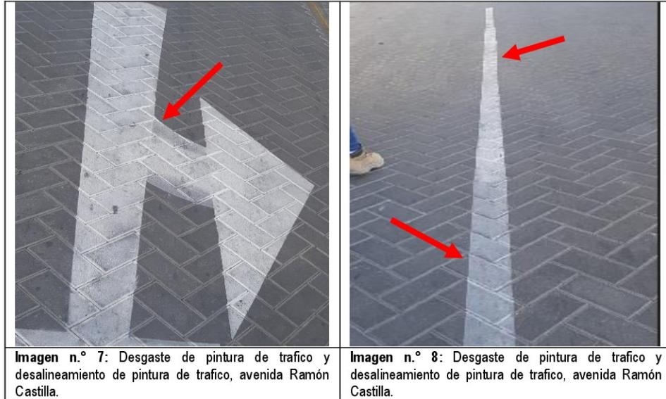
**Imagen n.º 7:** Desgaste de pintura de tráfico y desalineamiento de pintura de tráfico, avenida Ramón Castilla.
