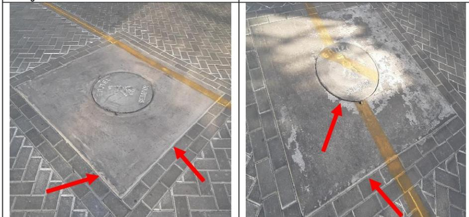
**Imagen n.º 3:** Tapa de buzón de concreto con desnivel con desprendimiento de concreto en bordes, ubicada en la avenida Ramón Castilla.
