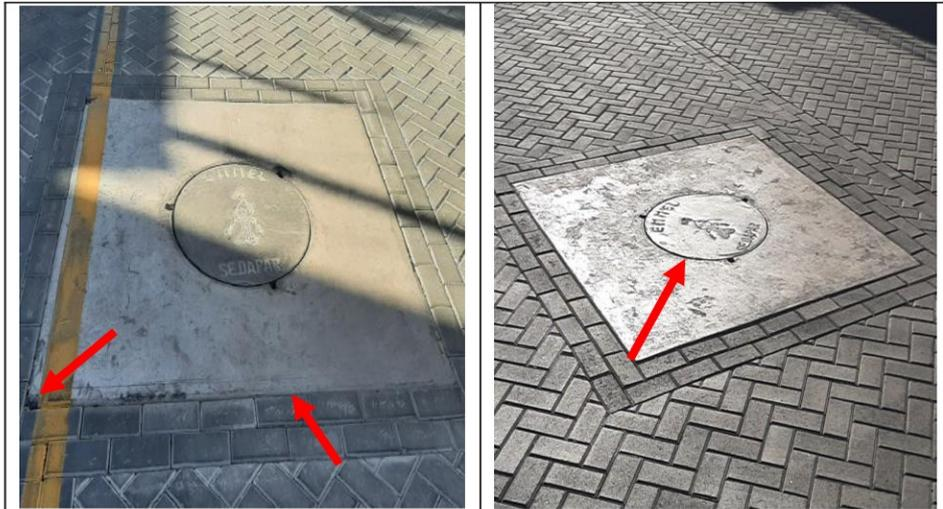
**Imagen n.º 1:** Tapa de buzón de concreto con desnivel con desprendimiento de concreto en bordes, ubicada en la avenida Ramón Castilla entre las calles 20 de abril y Gallegos.
