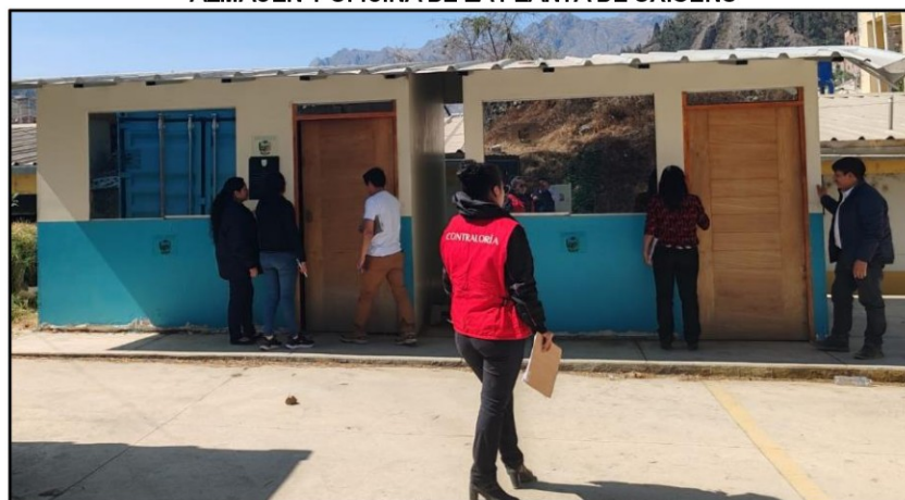
FOTOGRAFÍA N° 8 ALMACÉN Y OFICINA DE LA PLANTA DE OXÍGENO
