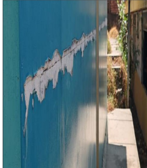
FOTOGRAFÍA N° 3 PARED DE LA OFICINA Y ALMACÉN
