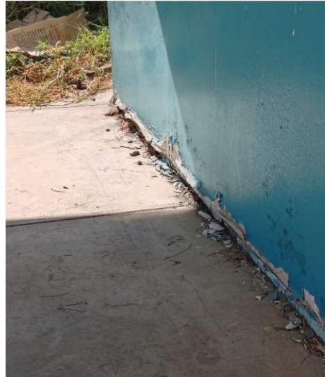
FOTOGRAFÍA N° 4 BASE DE PARED DE LA OFICINA Y ALMACÉN
