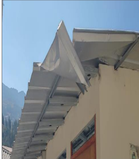
FOTOGRAFÍA N° 2 TECHO DE LA OFICINA
