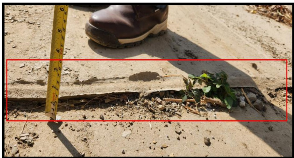
Fotografía n.º 9 Desnivel en paño de canal en progresiva (km 5+777)
