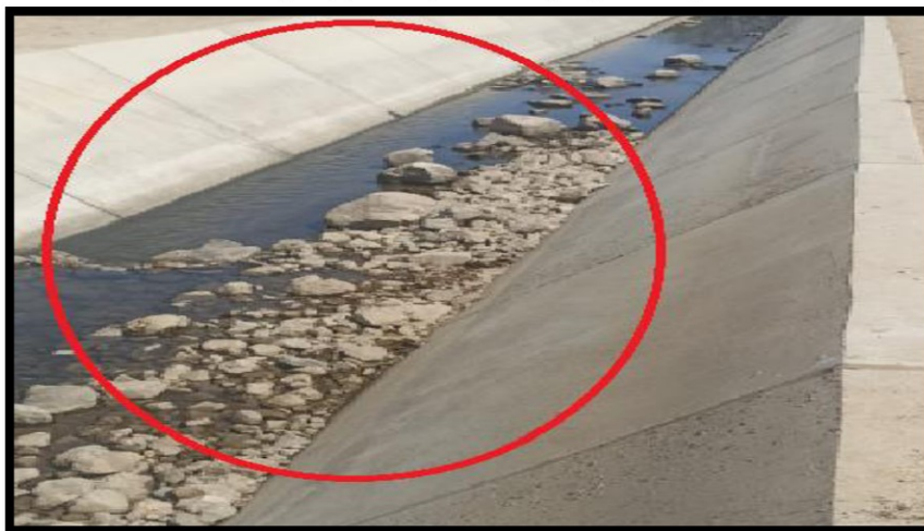
Fotografía n.º 13 Presencia de agua y piedras, entre las progresivas (km 0+000 – km 0+100)
