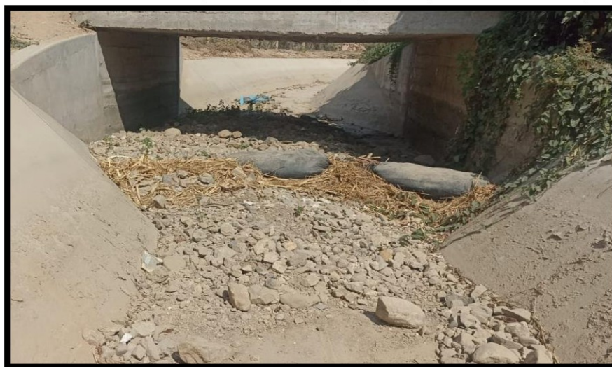
Fotografía n.º 14 Presencia de piedras, entre las progresivas (km 6+015 – km 6+022)
