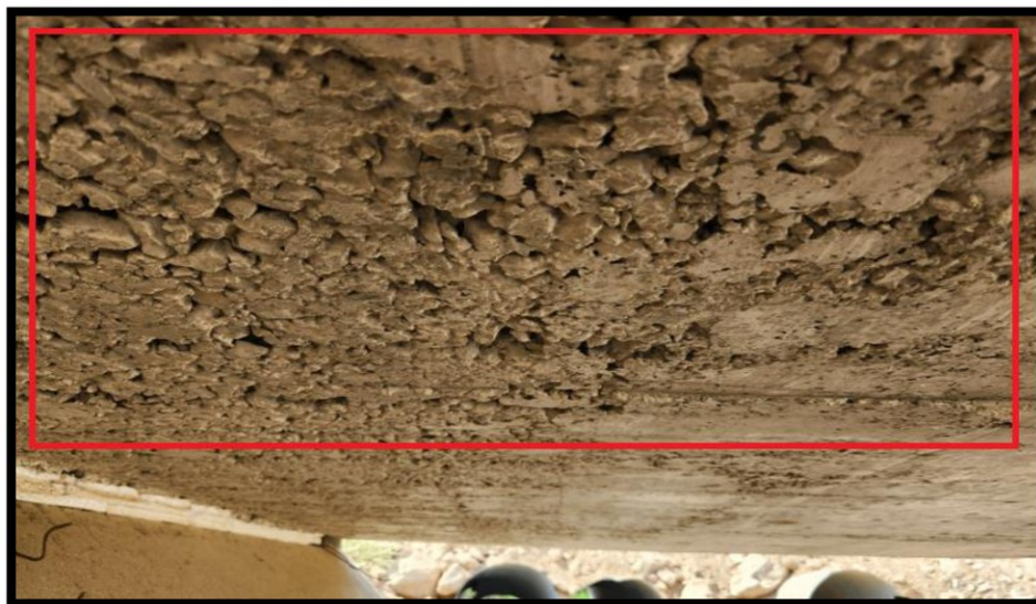
Fotografía n.º 2 Cangrejas en losa de puente n.º 1
