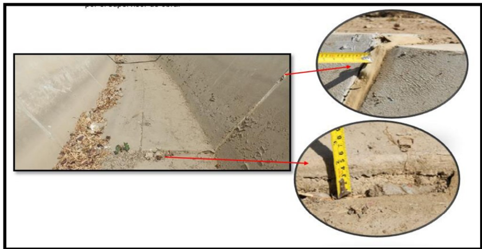
Fotografía n.º 8 Desnivel en paño de canal en progresiva (km 5+771)
