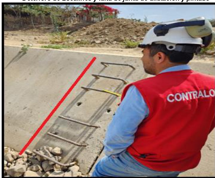
Fotografía n.º 10 Deterioro de Escalines y falta de junta de dilatación y pintado
