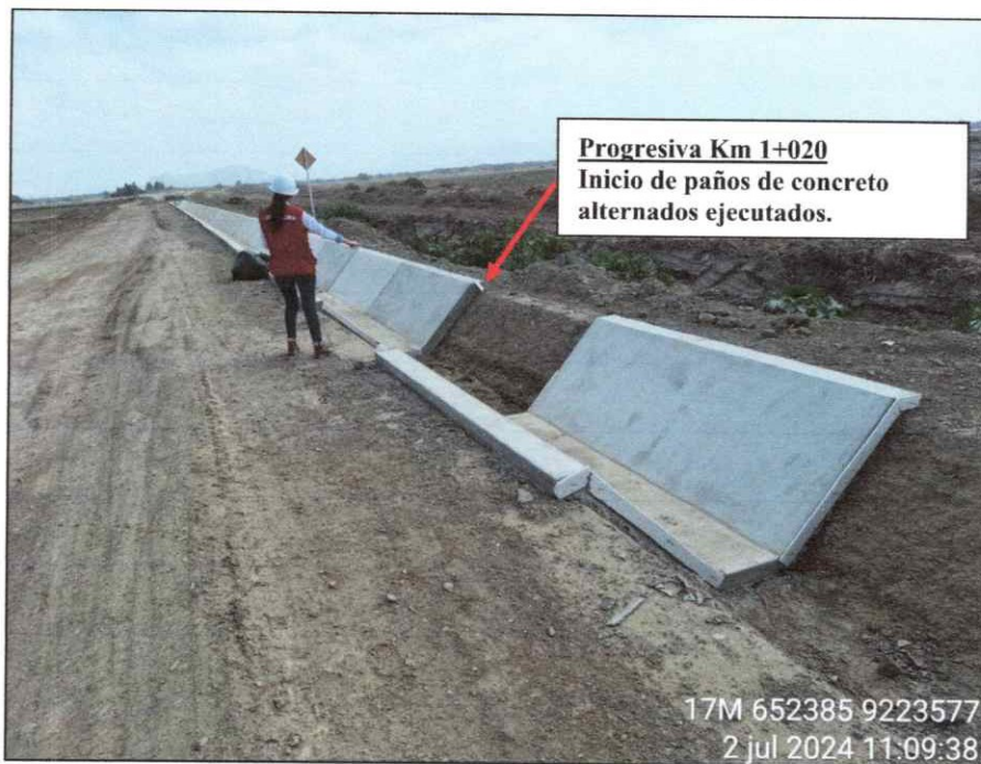
Imagen n.º 9 Paños ejecutados de concreto para revestimiento de canal carrizal
