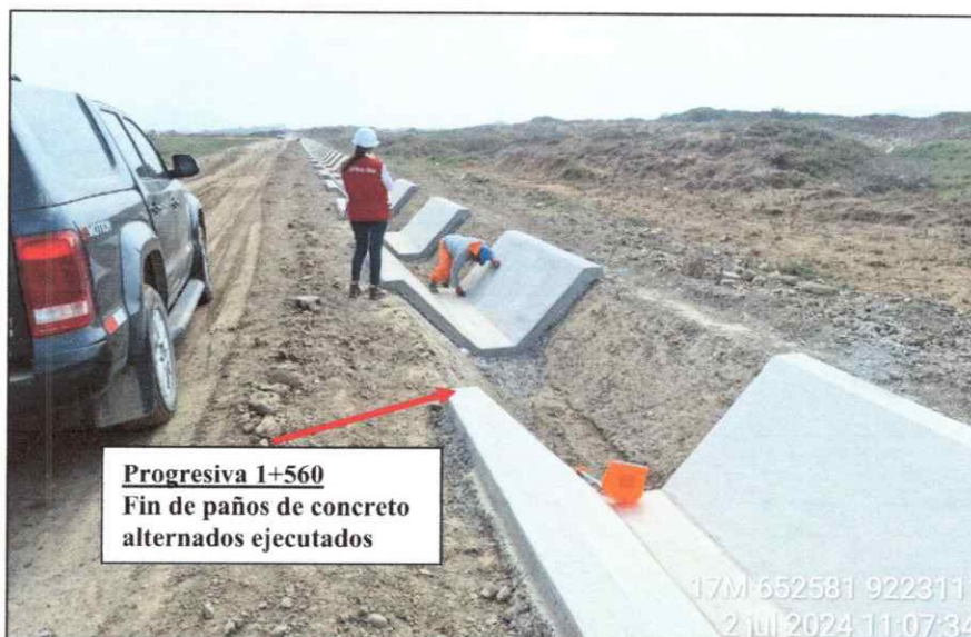
Imagen n.º 11 Paños de concreto alternados ejecutados para revestimiento de canal carrizal
