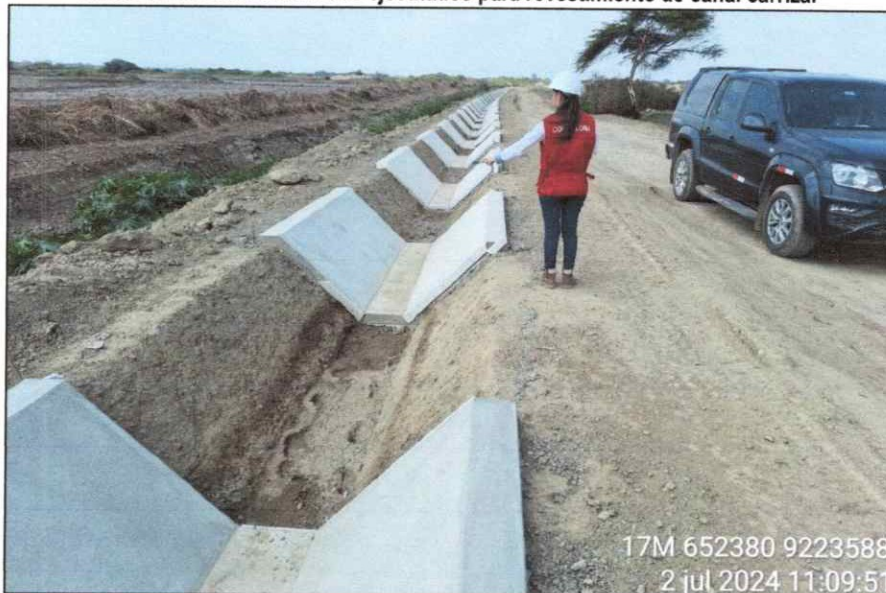
Imagen n.º 10 Paños de concreto alternados ejecutados para revestimiento de canal carrizal
