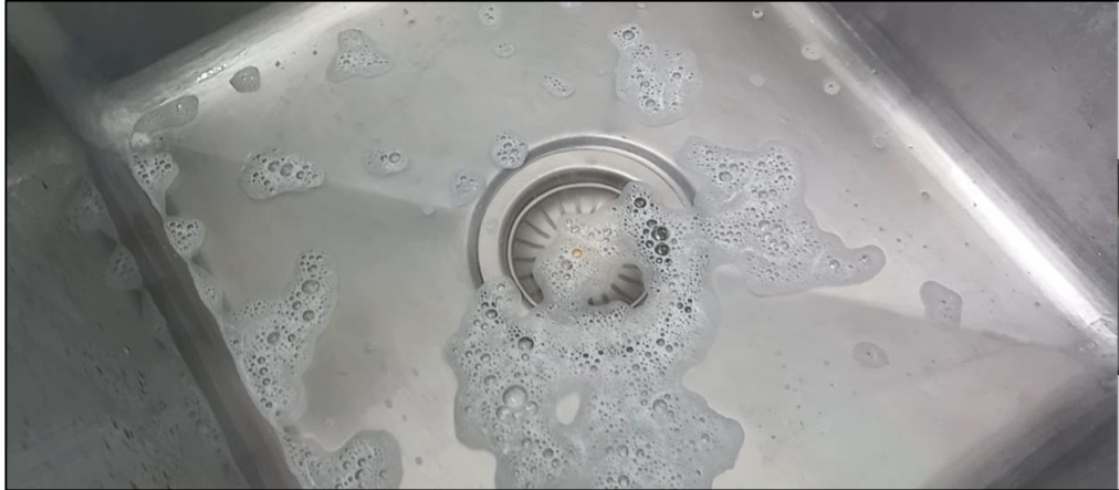
Imagen n.º 6 Estancamiento de agua en lavatorio de higienización 3
