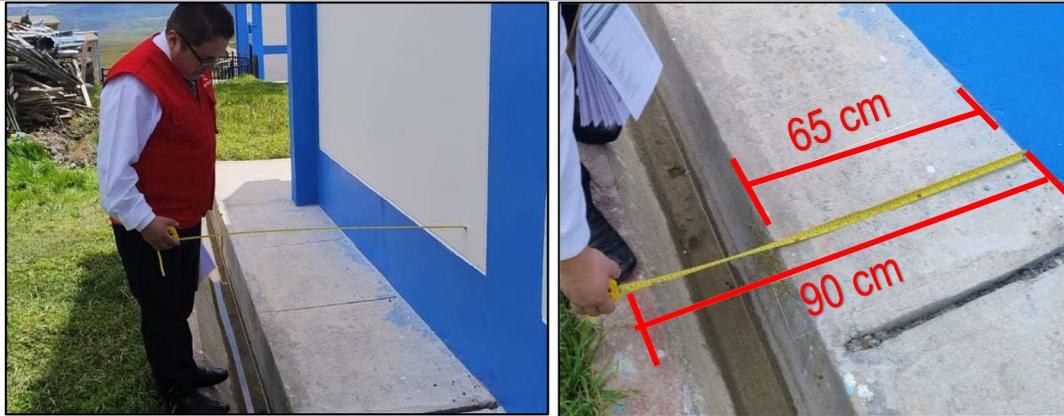
Foto n.º03 y n.º04: Se observa el ancho de la vereda que solo tiene 65 cm de ancho, no estando conforme a las condiciones técnicas establecidas en el Reglamento Nacional de Edificaciones.
