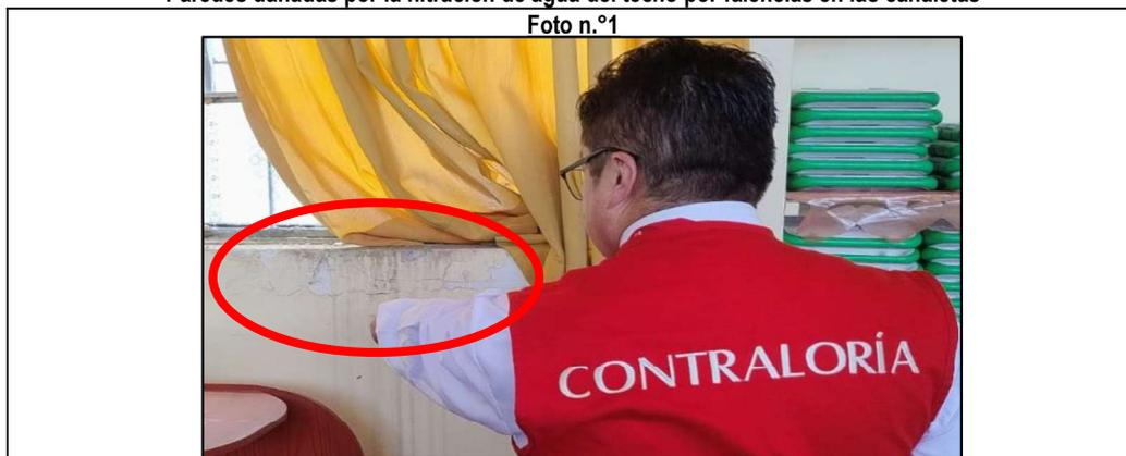
**Foto n.º1:** Se observa la filtración del agua, constatando que existe desprendimiento de pintura, y fisuras en el tarrajeo de la pared de un aula primaria, donde se advierte el mal estado de la canaleta.
