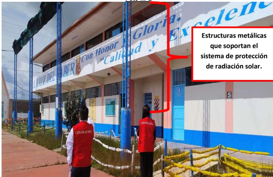
Foto n.º2: De la foto, se puede observar que los soportes para el sistema de protección para radiación solar, son estructuras metálicas, en las mismas que en la parte superior se encuentran motores eléctricos para desplegar la malla protectora; sin embargo de acuerdo a la versión de la directora de la institución educativa, nunca han funcionado.
