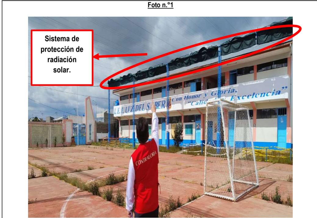
Foto n.º1: Se observa el sistema de protección contra radiación solar desplegable, impulsado por motores eléctricos instalados en la parte superior de la estructura metálica, los mismos que no funcionan.
