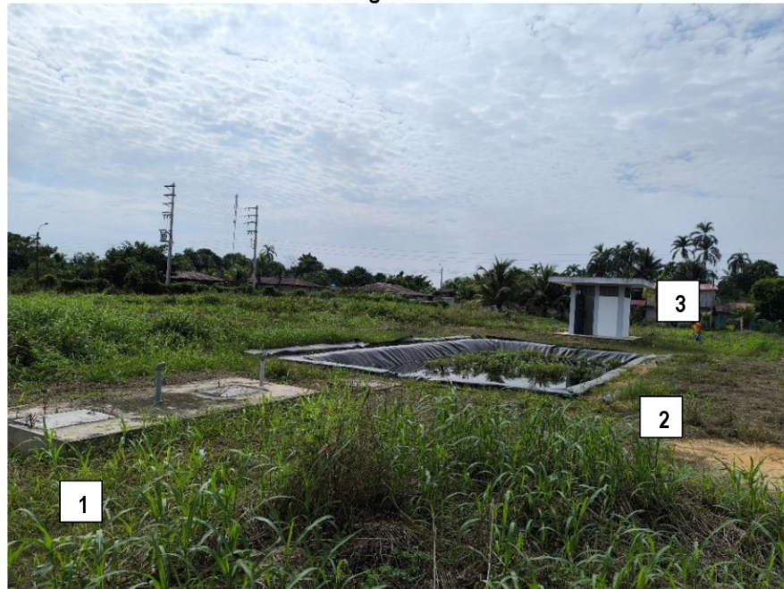
(1) Pozo séptico, (2) humedal artificial y (3) cámara de descarga para bombeo al sistema de riego
