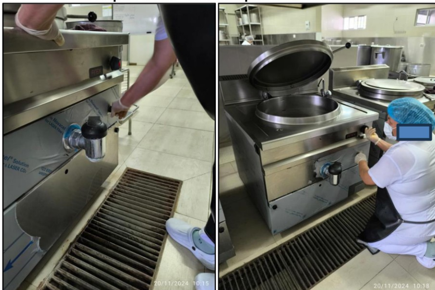
Imagen n.º 94 y 95 Retiro de perilla de una marmita para encendido de otros
