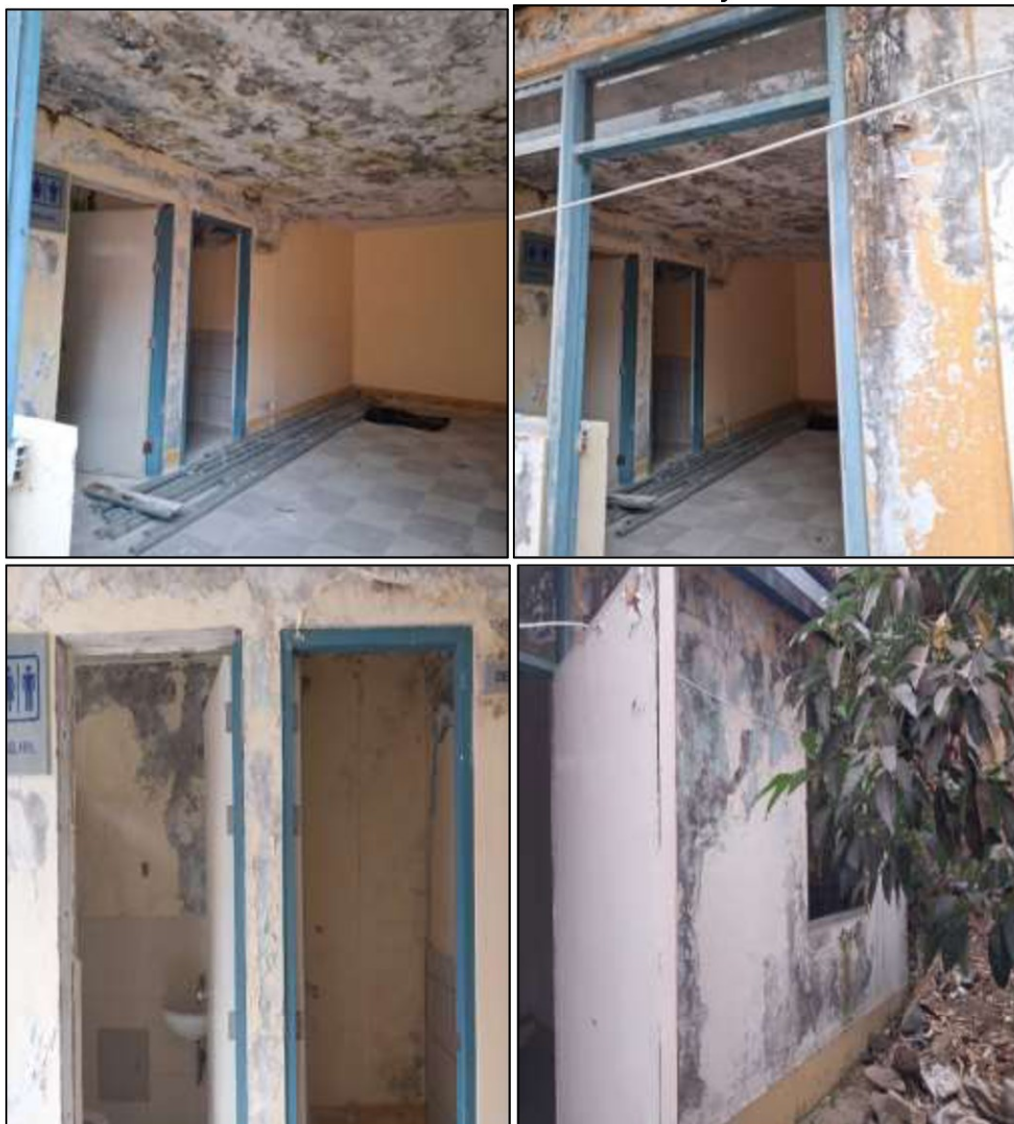
Imágenes n° 51, 52, 53 y 54 Infraestructura Conexa al Centro de Salud Yauyos
