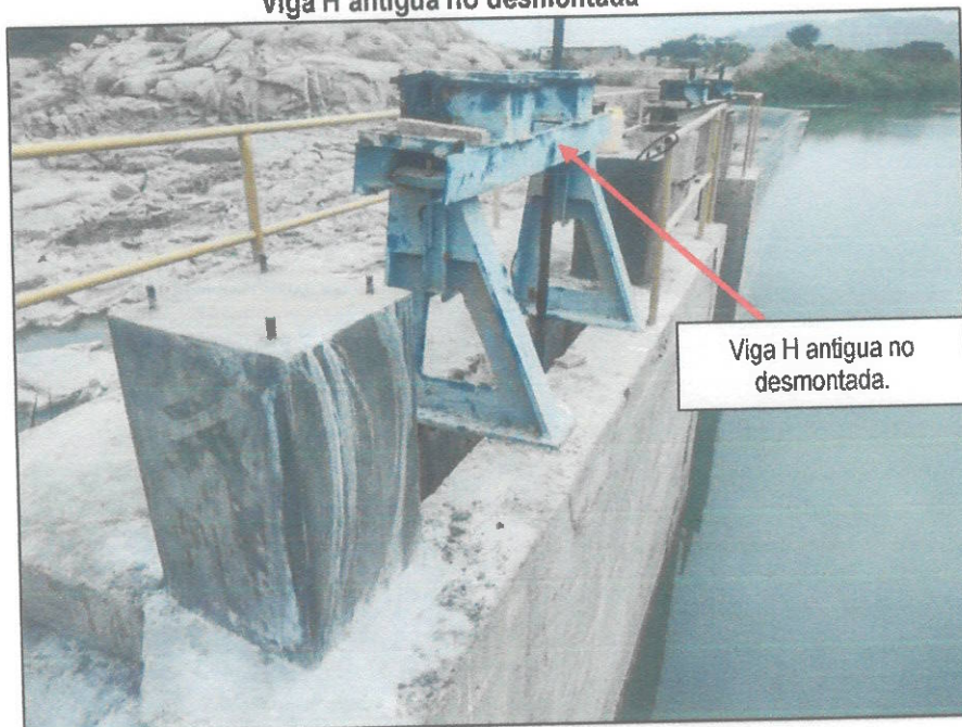
Imagen n.º 2 Viga H antigua no desmontada
