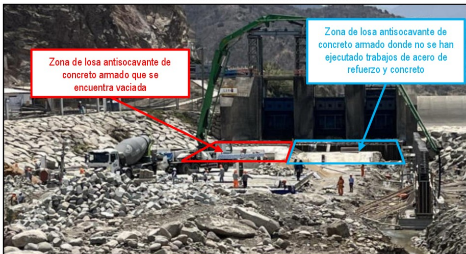
Imagen n.º 4 Vista frontal de la zona de la losa antisocavante
