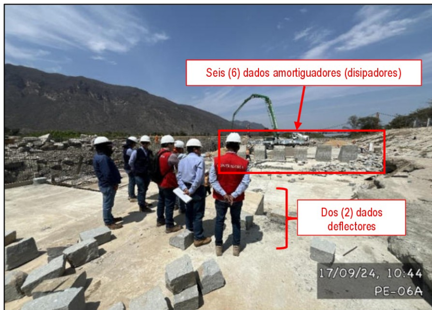
Imagen n.º 3 Vista posterior de la zona de la losa antisocavante
