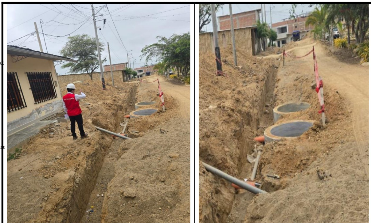
Fuente: Acta de inspección física n.º007-2024-MPT/OCI-SCC-2 de 28 de octubre de 2024.
