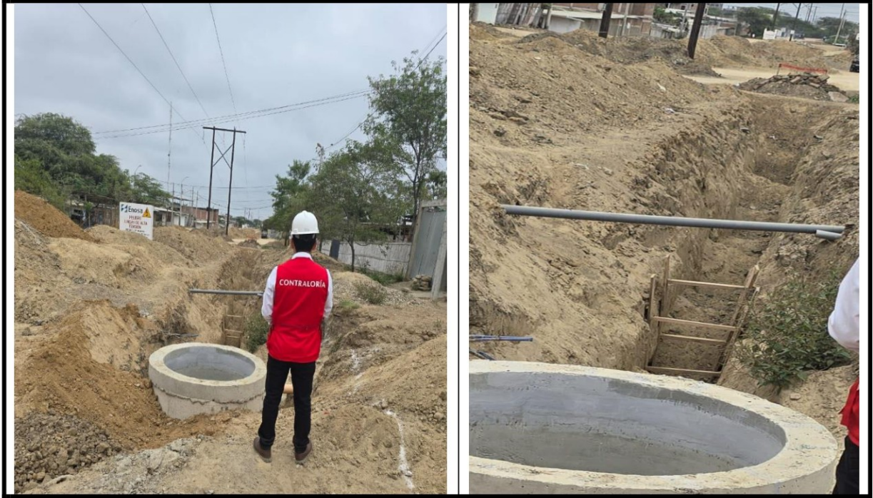
Fuente: Acta de inspección física n.º007-2024-MPT/OCI-SCC-2 de 28 de octubre de 2024.
