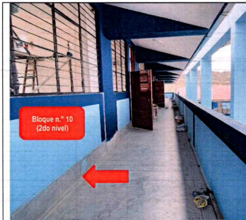
Registro fotográfico n.º 32 Pintura en contrazócalo
