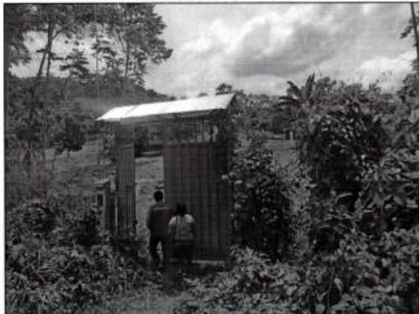
Imagen n.º 1 Carencia de Cerco Perimétrico
