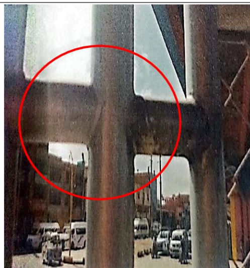
Fotografía n.º 7: El trabajo de la soldadura no es uniforme y continuo.
