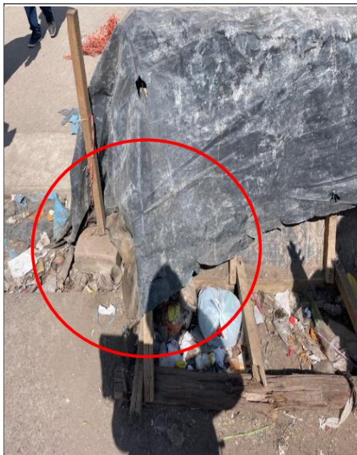
Fotografía n.º 19: Falta de cintas de seguridad y señalización en obra.
