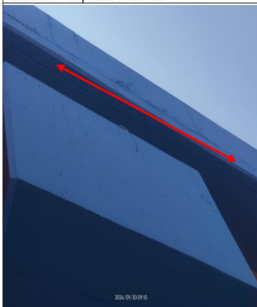
Fotografía n.º 3: Se muestra falta de trabajos de lijado y rellenado en barrera.
