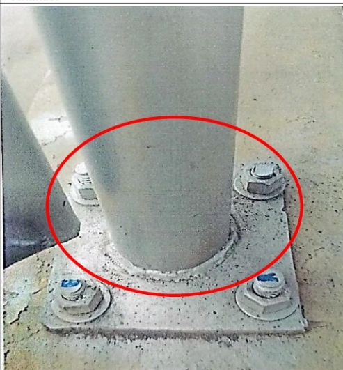
Fotografía n.º 8: El trabajo de la soldadura no es uniforme y continuo.
