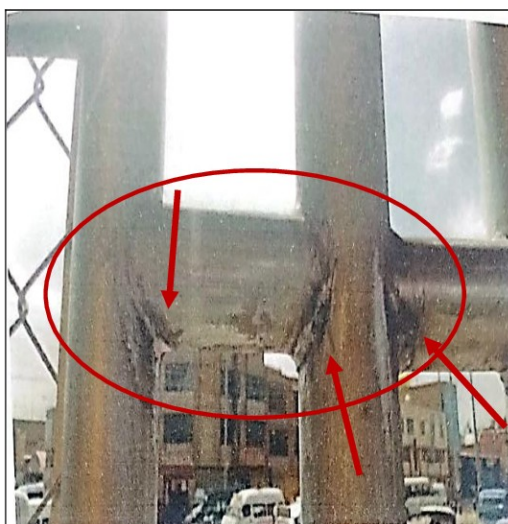
Fotografía n.º 5: El trabajo de la soldadura no es uniforme y continuo.
