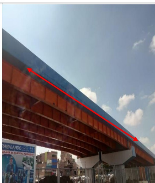
Fotografía n.º 2: Inadecuadas condiciones de delimitación del pintado en barrera.
