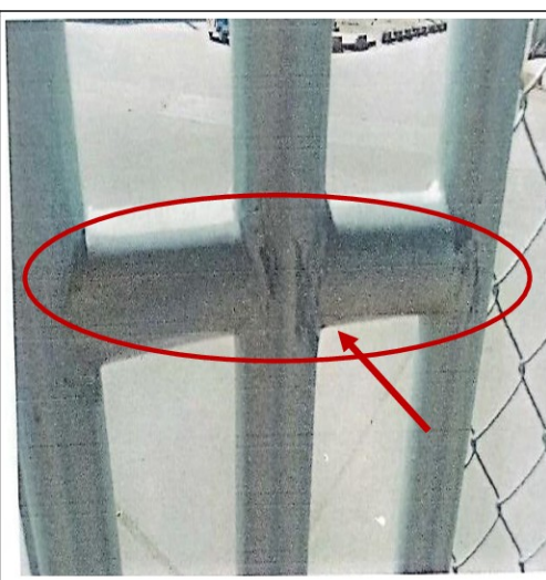
Fotografía n.º 6: El trabajo de la soldadura no es uniforme y continuo.
