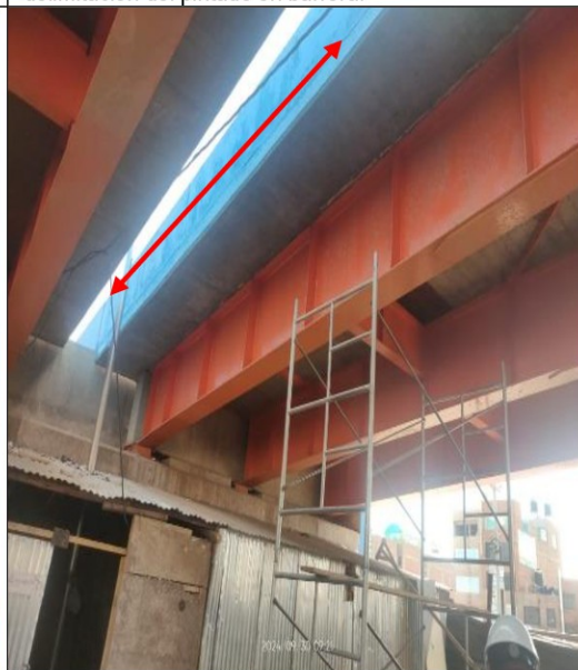
Fotografía n.º 4: Se muestra falta de trabajos de pintado, lijado y rellenado en barrera.
