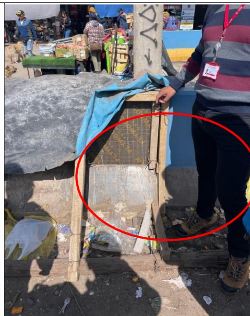
Fotografía n.º 20: Falta de señalización en excavaciones.
