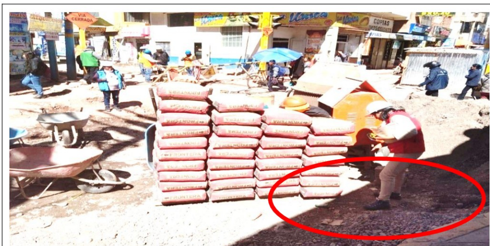
Fotografía n.º 3: Presencia de plástico y tierra no se verifica una adecuada dosificación.
