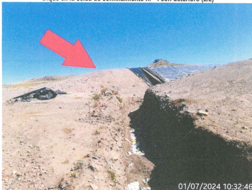
Imagen n.º 9 Dique en la celda de confinamiento n.º 4 con deterioro (2/2)
