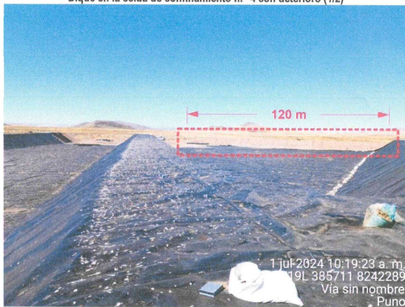
Imagen n.º 8 Dique en la celda de confinamiento n.º 4 con deterioro (1/2)
